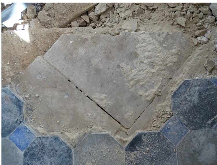
odkrywka ukazująca fragment piaskowcowej XVIIIw. posadzki piaskowcowej pod XIXw. posadzką ceramiczną w holu
