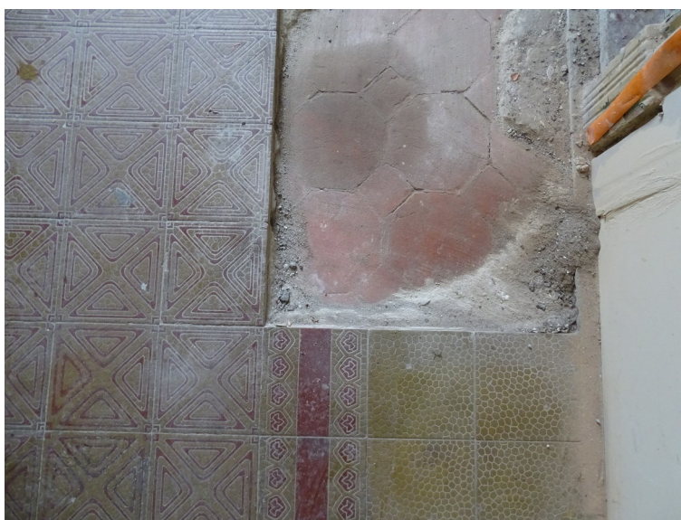
odkrywka ukazująca fragment ceramicznej posadzki z XVIIIw. pod posadzką z pocz. XXw. w północnym korytarzu
